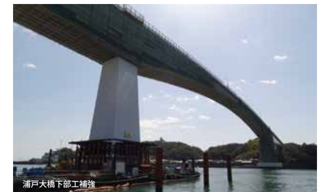
浦戸大橋下部工補強
