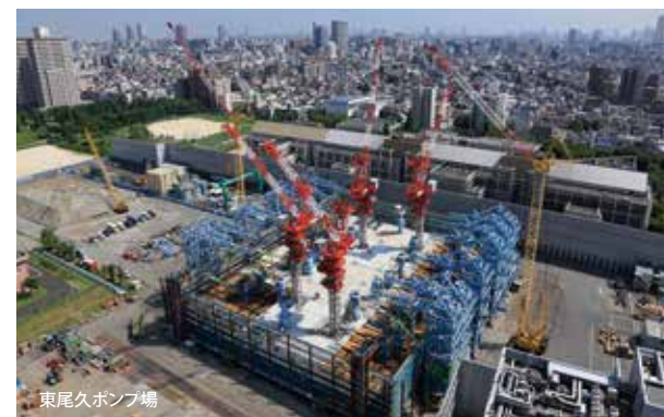
東尾久ポンプ場
