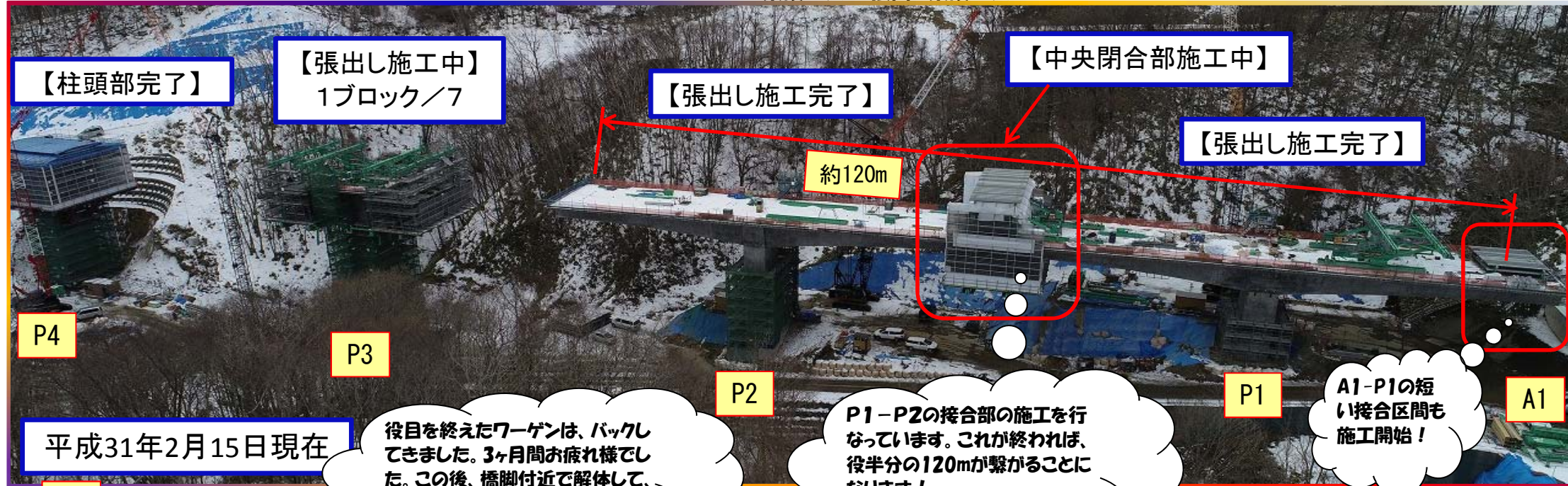
【ワーゲン前進移動・型枠組立】
