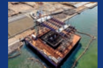
鎮守大橋ケーソン
