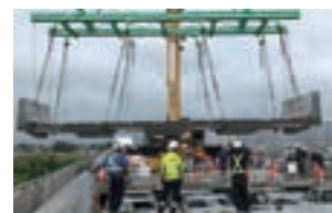
北陸自動車道富山立山間床版取替工事
