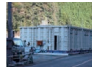
ケーソン現場における騒音対策 法律に定める特定建設作業における騒音の抑制のため、ケーソン送気設備を防音ハウスにて覆っています。
