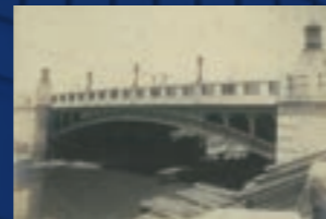
岩井橋完成時(名古屋市)
