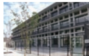
岩国市立岩国東小中学校建設工事
