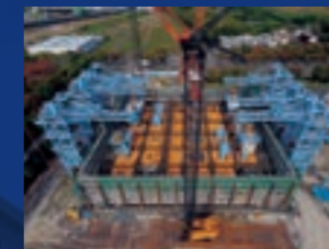
呑龍ポンプ場
