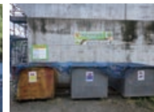
工事現場における産業廃棄物の保管 廃棄物の処理及び清掃に関する法律に基づき産業廃棄物の保管を行っています。
