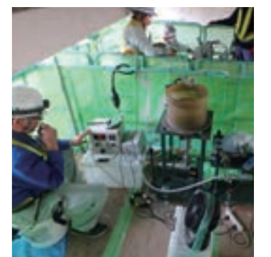
空洞推定状況
