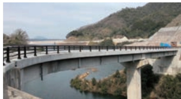
橋梁PC桁への適用事例
