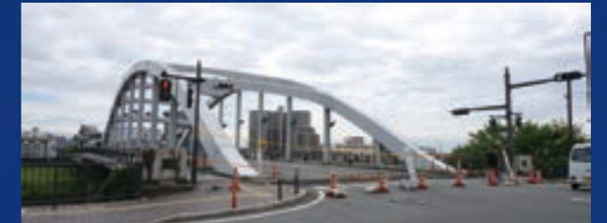
白川橋応急復旧工事
