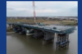
早津江川橋上部工工事
