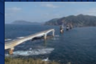
蘭牟田(いむた)瀬戸架橋第2橋(1工区)工事
