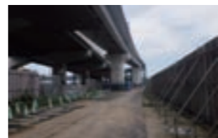
第601工区(香椎浜)高架橋
