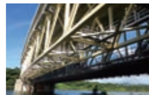
億首川橋(上り線)他2橋床版取替
