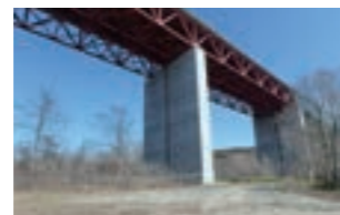
メップ川橋応急復旧工事
