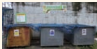
工事現場における産業廃棄物の保管 廃棄物の処理及び清掃に関する法律に基づき産業廃棄物の保管を行っています。
