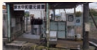
工場における排水測定 水質汚濁防止法に基づき排水時にpH調整を行い高アルカリ水の排出を抑制しています。定期測定の結果、3工場全てにおいて基準値を超える排出がないことを確認しています。
