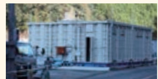
ケーソン現場における騒音対策 法律に定める特定建設作業における騒音の抑制のため、ケーソン送気設備を防音ハウスにて覆っています。
