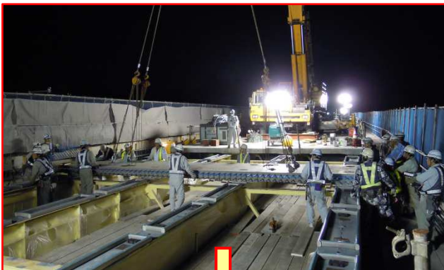
PCa 床版架設
