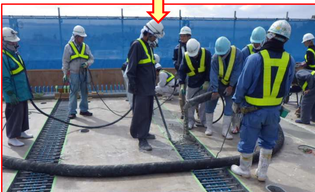
間詰部コンクリート打設
