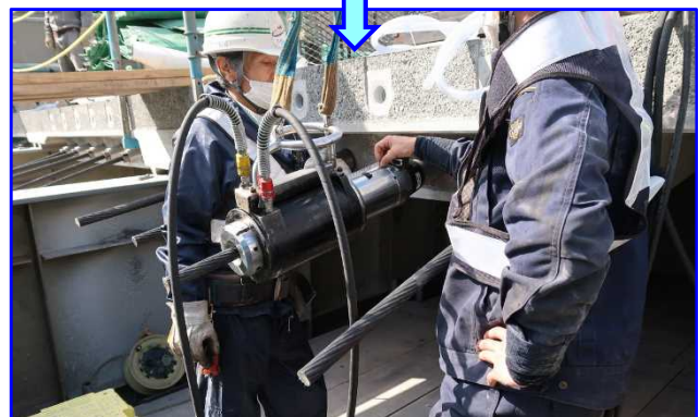
橋軸方向ポステン緊張
