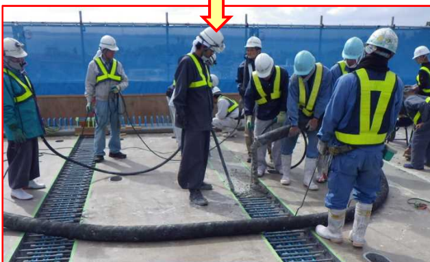
間詰部コンクリート打設
