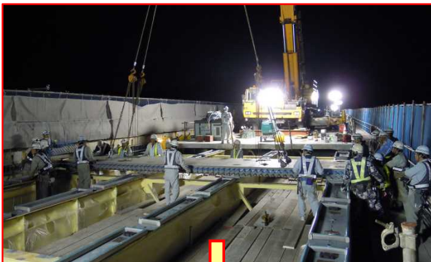
PCa 床版架設
