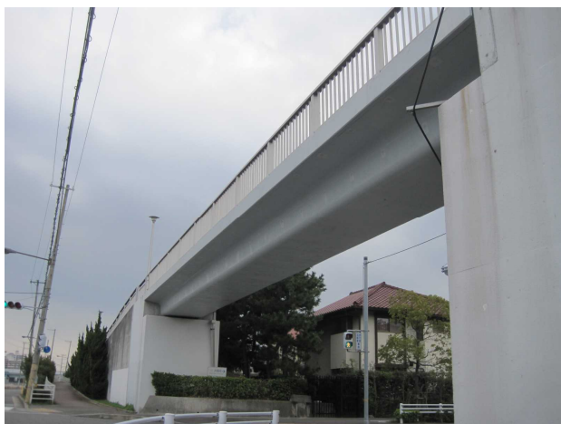
打出浜歩道橋(兵庫県)
