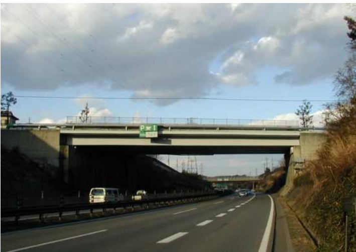
大山田第二橋(三重県) , 高速道路跨道橋
