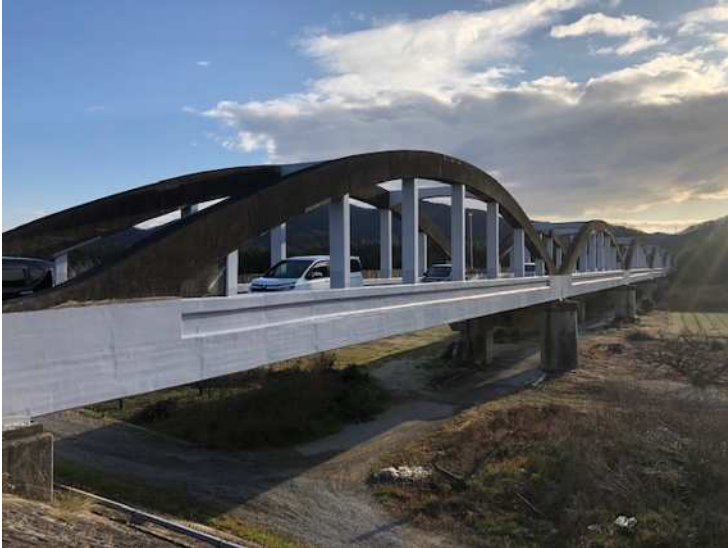
大原橋(岡山市)，RC橋
