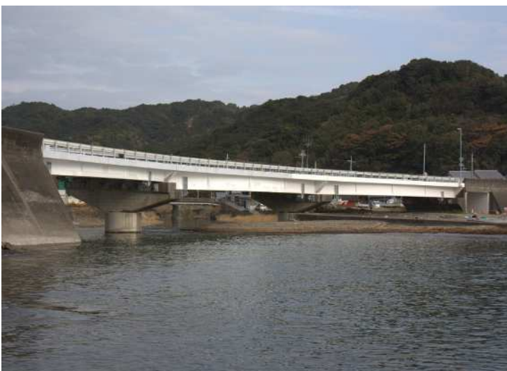
津荷橋(和歌山県)，PC橋・海上
