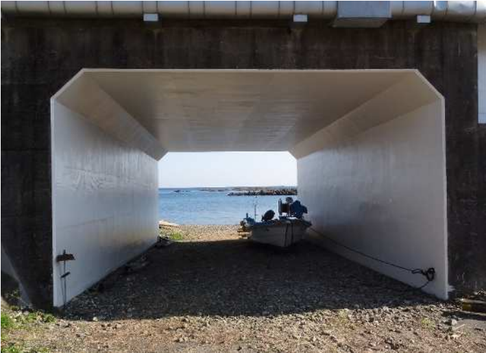
津荷橋(和歌山県) , ボックスカルバート
