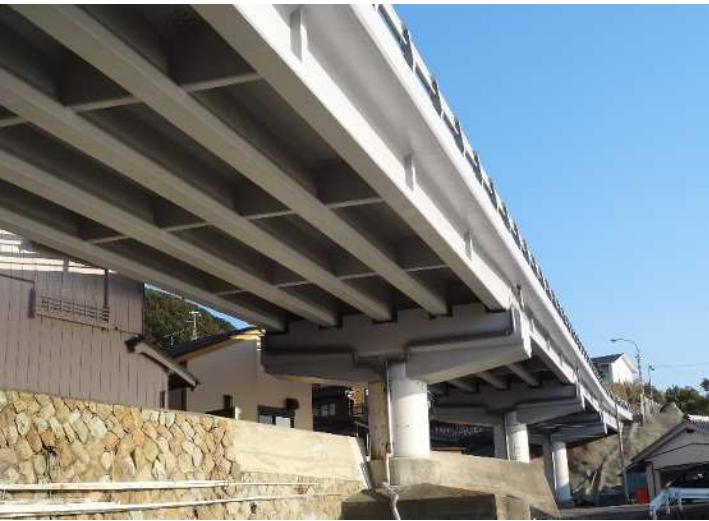
見老津高架橋(和歌山県) , PC橋
