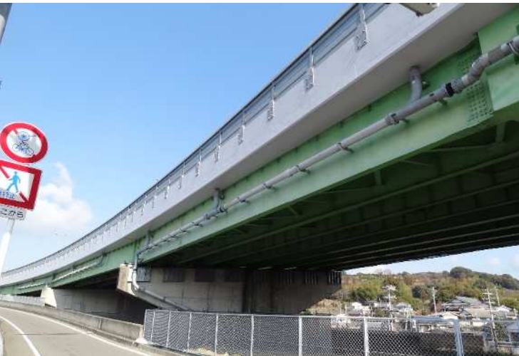
秋津高架橋(和歌山県)，鋼桁橋・壁高欄
