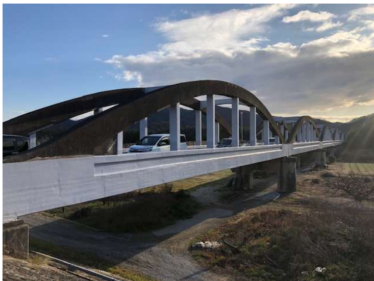
大原橋(岡山市)，RC橋
