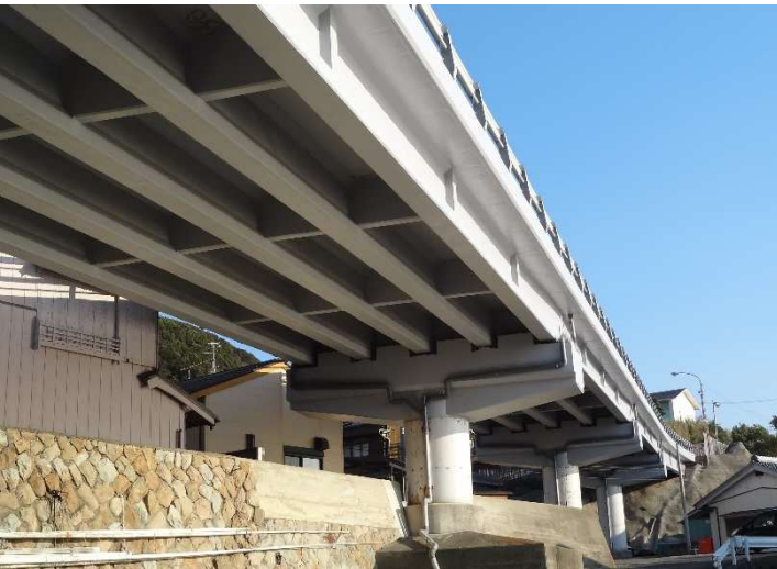
見老津高架橋(和歌山県)，PC橋
