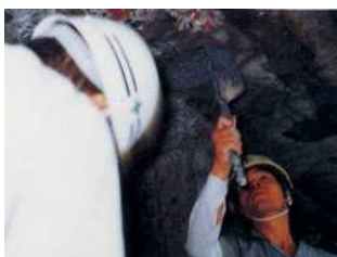
前処理, 下地調整 (セルタルペーストP塗布)
