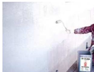
3. 中塗り・補強シート (オーソレNA・NSVシート)
