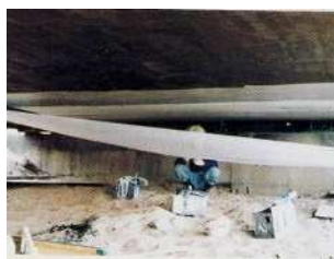
4. 補強シート (NSVシート貼り付け)
