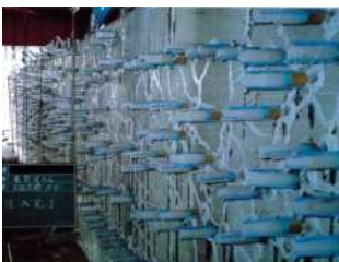
前処理 クラック注入 (セルタルペーストP塗布)
