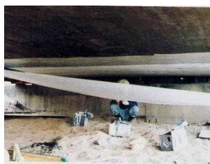
4. 補強シート (NSVシート貼り付け)
