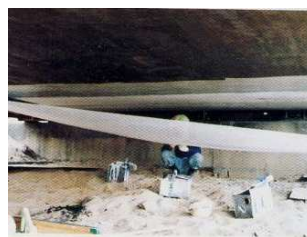
4. 補強シート (NSVシート貼り付け)
