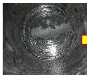
開削前（孔内処理後）
