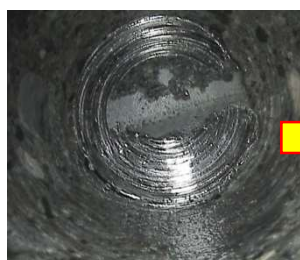
開削前（孔内処理後）
