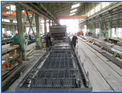
コンクリート打設
