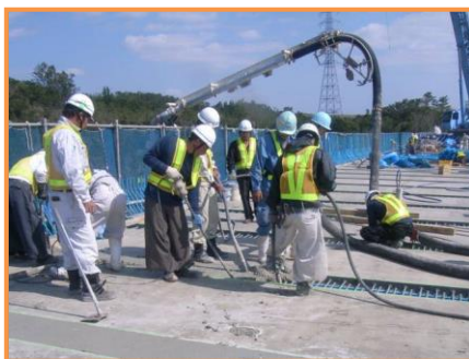
コンクリート打設
