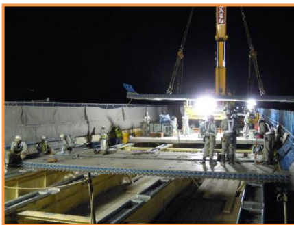
SLJスラブ架設
