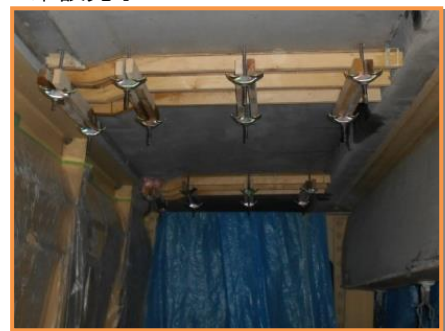
接合部型枠設置
