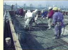
8. トップコンクリート打設
