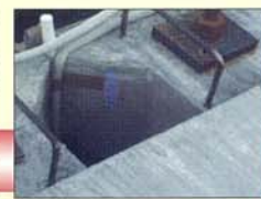
壁版縦側接合部 コンクリート打設 ..... 接着剤塗布
