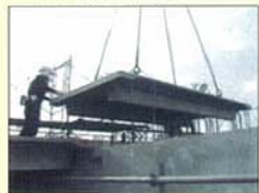
5. 合成床版架設
