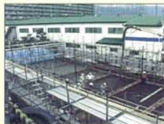
3. 底版コンクリート打設
