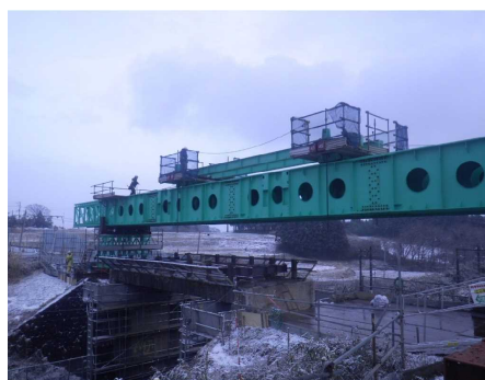
PC 単純桁床版橋の施工事例
