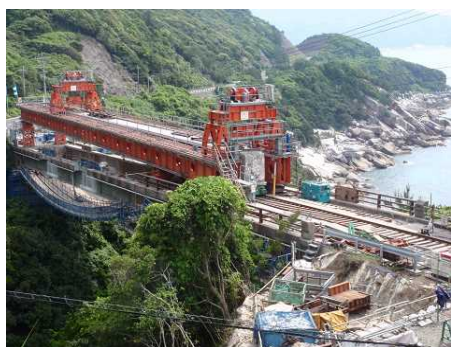
PC2 径間ポストテンション単純 T 桁橋の施工事例
