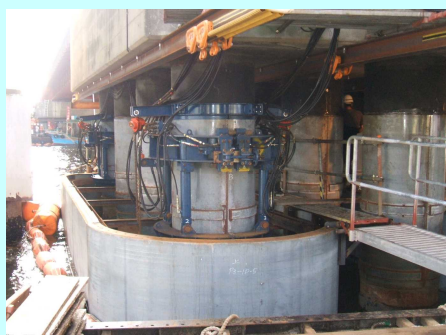
Kui Taishin-SSP工法での施工事例 小判形(10.6×3.2m)
