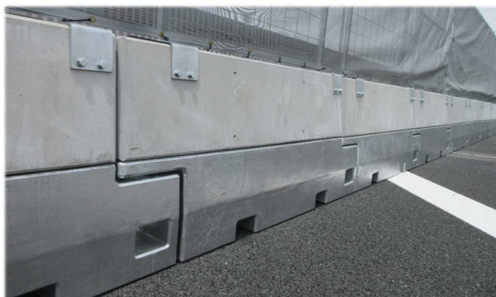
連結したハイブリッドスリムガード設置状況
