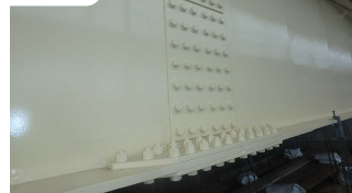
添接板 取替後
