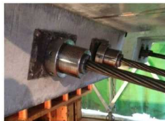
ケーブル緊張端(HGグリップ設置状況)
