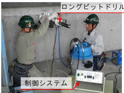
ロングビットドリルによる小径削孔
