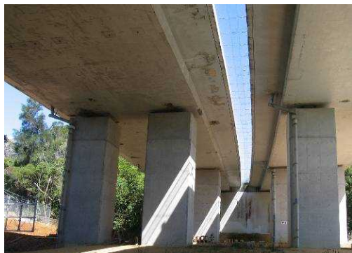
架替え前のRC中空床版橋
