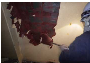
スクレーパーで被膜を剥離
