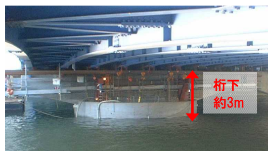
基礎が大きい ⇒ 基礎天端設置形式
