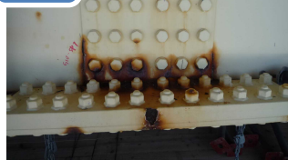
添接板 取替前
