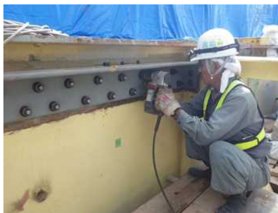
高力ボルト締め付け
