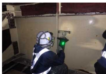
IH式装置で鋼板を加熱
