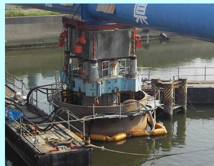
PCウエルリフレ工法での施工事例 円形(φ5.0m)
