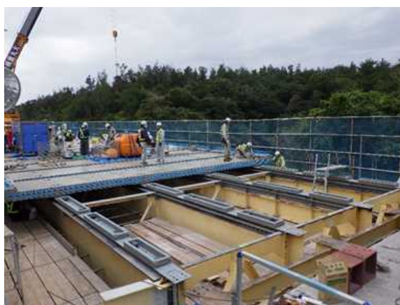
既床版完全撤去
