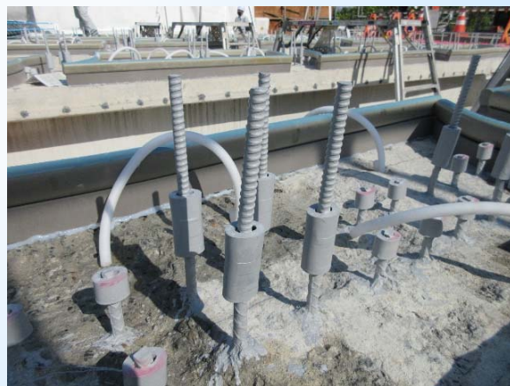
<鋼管圧着完了>
