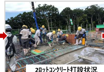
2口コンクリート打設状況
