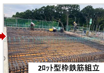
2口型枠鉄筋組立
