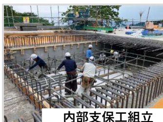
内部支保工組立
